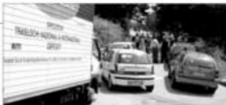
Il cantiere per il centro oncologico di Irpinia
