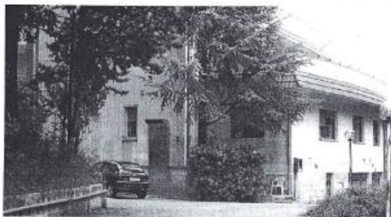
Mercogliano - L'ex Ipai, la struttura che dovrebbe ospitare il centro oncologico pediatrico
